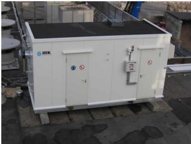
Figuur 4: Warmtepomp bij Smurfit Kappa, stoom 115 °C, foto ECN. Rechts : schematisch een tegenstroom cascade warmtepomp.
