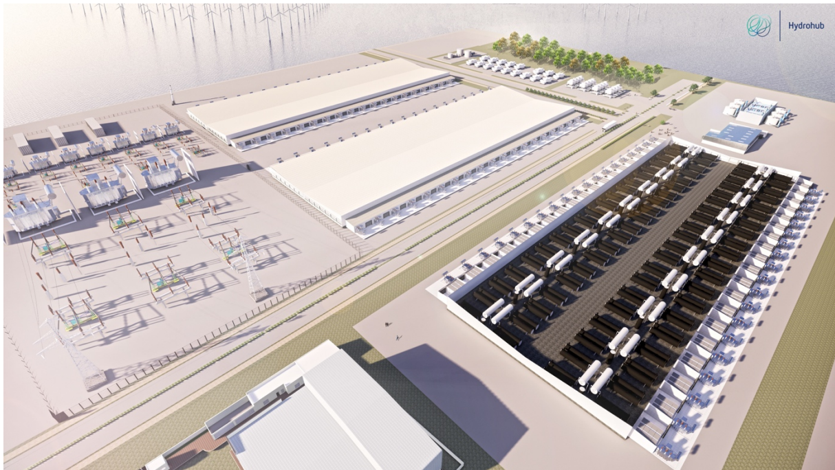
Artist impression van een gigawatt groene waterstof facility, gebaseerd op Alkaline electrolyse design
